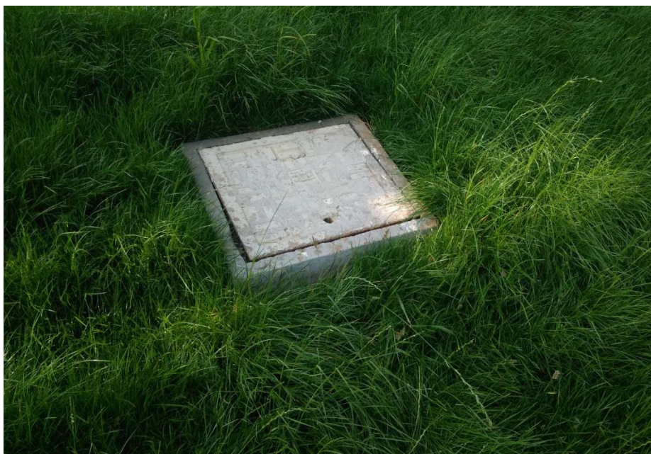
地下水监控井
