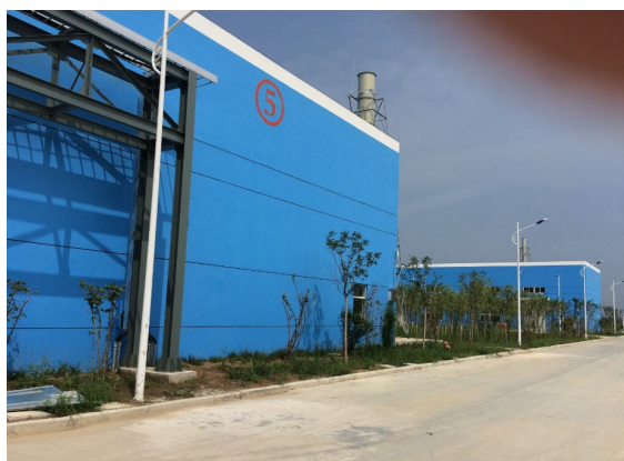
危险废物暂存库
