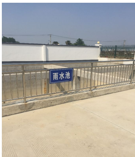
初期雨水收集池
